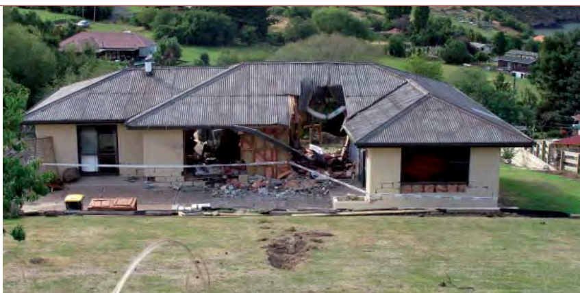
Figura 11: Ejemplo del impacto de una roca de gran tamaño en una casa de los barrios periféricos ubicados sobre laderas (se observa el rastro dejado por la roca en primer plano) (imagen de arriba) y del derrumbamiento de un barranco que amenaza a las casas y sus ocupantes tanto en la cima como en la base de la pendiente (imagen de abajo) (imágenes de D. Barrell y G. Hancox, GNS Science).
