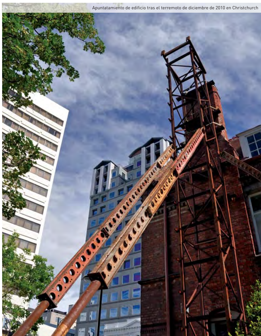
Apuntamiento de edificio tras el terremoto de diciembre de 2010 en Christchurch
