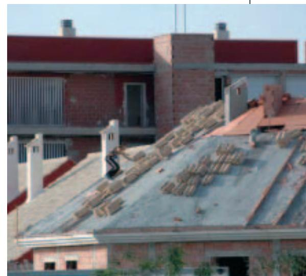
**Fotos 17 y 18.** Dos ejemplos del elevadísimo riesgo de caída a distinto nivel en forjados inclinados.
