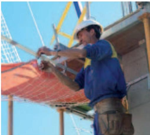
En este momento tenemos instalada una línea de anclaje, con la particularidad de que se encuentra ubicada en la parte superior del pilar.
