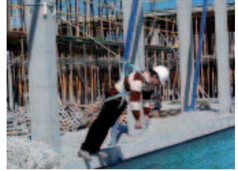
**Fotos 3 y 4.** El operario, una vez fijado el anclaje a un punto resistente, puede sujetarse al Sistema SIP con total seguridad.
