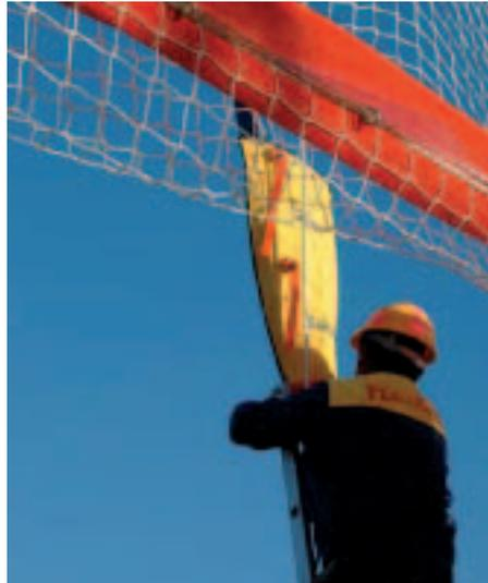
**Fotos 25, 26 y 27.** Instalación de redes de seguridad del sistema V entre las horcas y los pilares, con posibilidad de incorporar un protector acolchado abrazando a la horca metálica.
