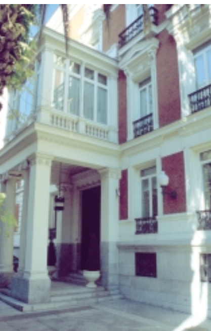
Entrada de la sede de MAPFRE RE en Paseo de Recoletos, 25.
