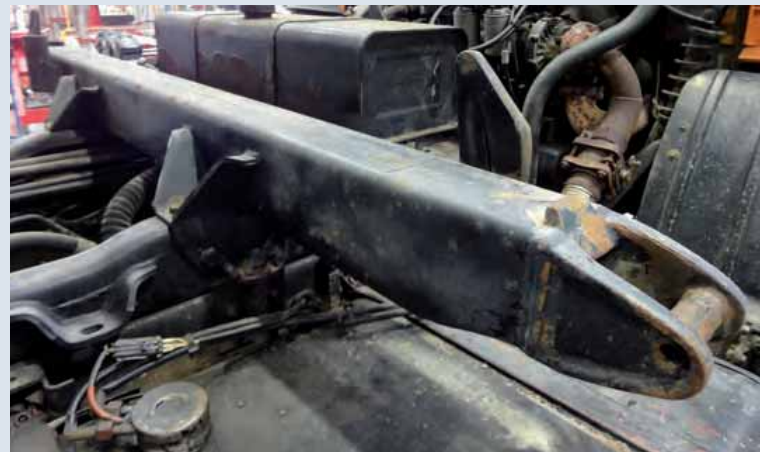
Apoyo sobre el que descansa la caja
